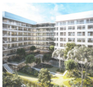
Evidence - Zac des Docks 93400 Saint-Ouen - VEFA
