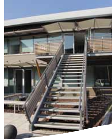
AVIGNON (84) Route de l'aéroport
