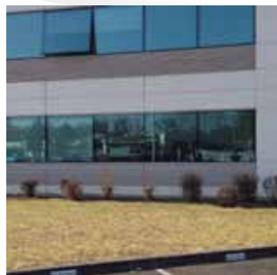
ILLKIRCH (67) Le Fermat Rue Sébastien Brandt
