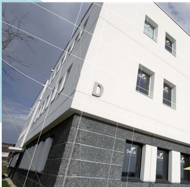
NANTES (44) Rue du chemin rouge
