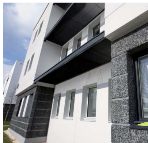
NANTES (44) Rue du chemin rouge
