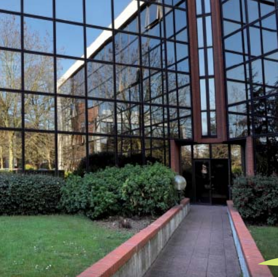
VELIZY (78) Rue du Petit Clamart
