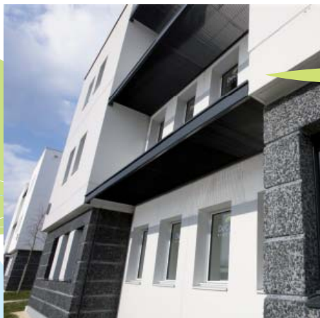
NANTES (44) Rue du chemin rouge
