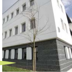
NANTES (44) Rue du chemin rouge
