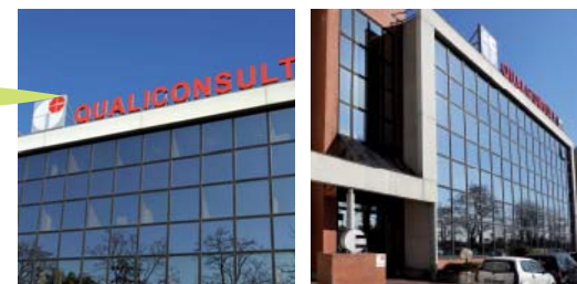
VELIZY (78) Rue du Petit Clamart
