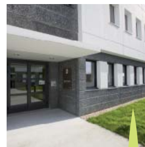
NANTES (44) Rue du chemin rouge
