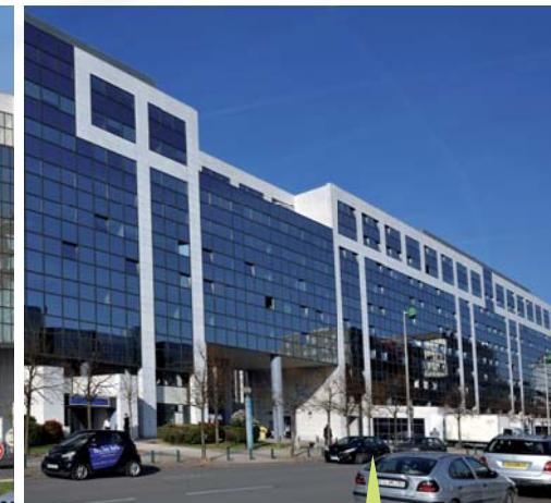
Noisy le Grand (93) Avenue Montaigne
