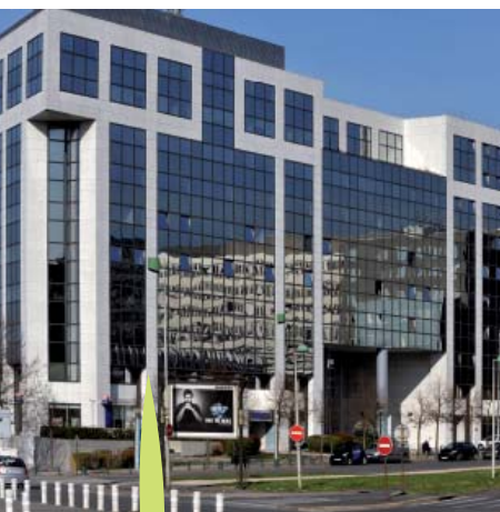
NOISY LE GRAND (93) Avenue Montaigne
