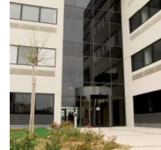
COLOMIERS (31) Eolis 2 Avenue Yves-Brunaud
