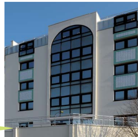
IVRY (94) Rue Maurice Grandcoing
