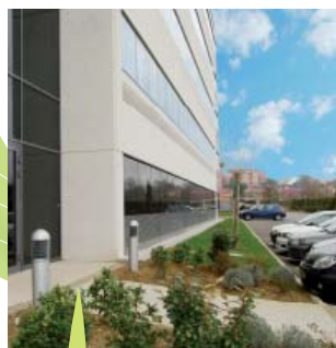
COLOMIERS (31) Eolis 2 Avenue Yves Brunaud
