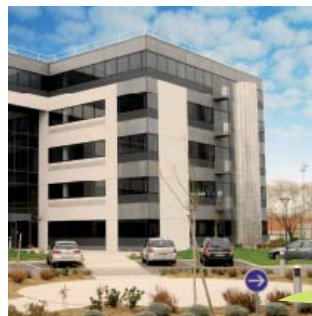
COLOMIERS (31) Eolis 2 Avenue Yves-Brunaud
