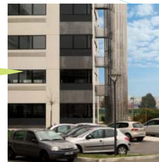
COLOMIERS (31) Eolis 2 Avenue Yves-Brunaud
