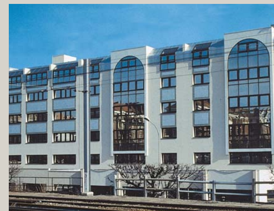
Renouvellement de bail à Ivry sur Seine (France Telecom)
