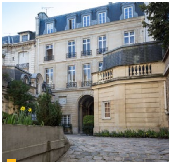
51, rue de Monceau à Paris 8 ème
