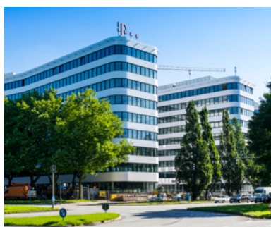
Telekom Campus - Überseering 2 22297 Hamburg - Allemagne
