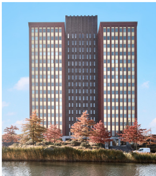
Fascinatio boulevard 350 - Rotterdam (Pays-Bas)
