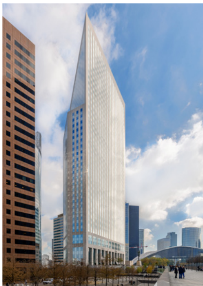
Tour Egée - 9-11 allée de l'Arche - 92400 Courbevoie
