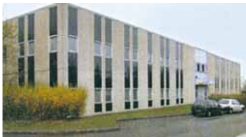
3, avenue des Ormeaux Montigny Le Bretonneux (78)
