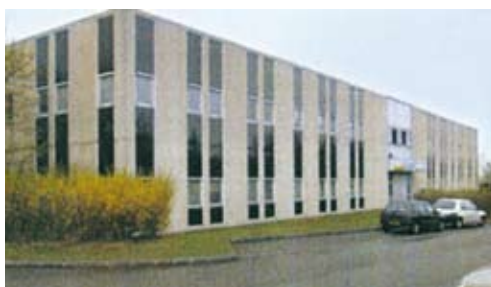
3 avenue des Ormeaux Montigny Le Bretonneux (78)
