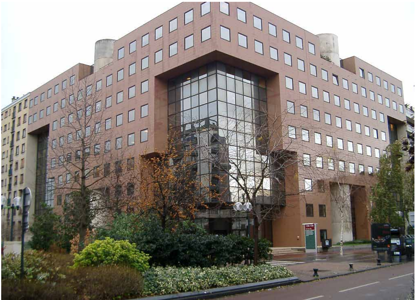
Allianz Pierre - 130-136 rue de Sily - Boulogne-Billancourt (92)
