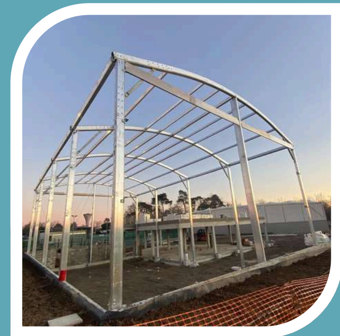
Construction du centre de padel à Camblanes-et-Meynac (33)
