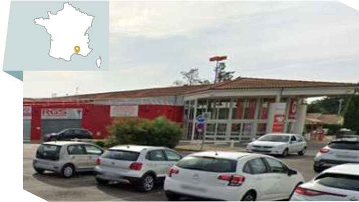
Galerie Saint-Victoret | SAINT VICTORET
